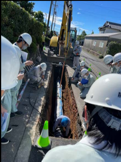
①掘削・管設置
